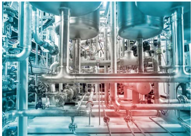
Druckprüfung nach mechanischer Fertigstellung
