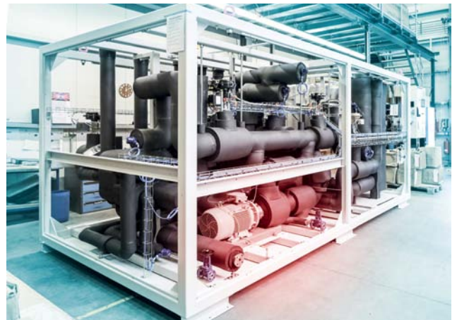
Isolierung nach erfolgreicher Prüfung
